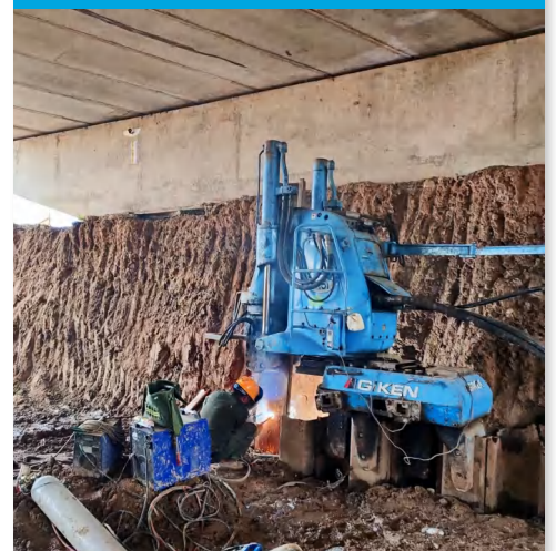
Thi công nổi cọc trong không gian hạn chế chiều cao 低净空、接桩施工
