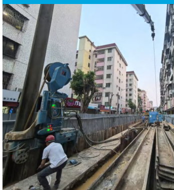
Cải tạo hệ thống ngầm tại khu đô thị cũ 老城区管网改造
