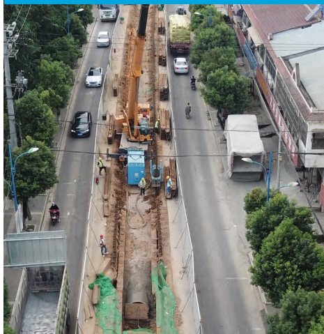
Cải tạo hệ thống hạ tầng ngầm, giảm thiểu ảnh hưởng giao thông 管网改造, 减少周边交通影响
