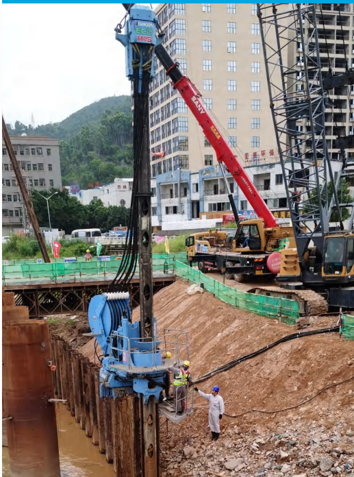
Vòng vây trụ cầu và địa chất phức tạp 桥墩围堰、复杂地层
