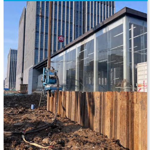
Khu vực lân cận đường tàu điện ngầm 临近地铁
