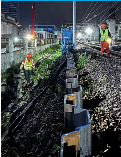
Thi công cạnh tuyến đường sắt 临近铁路
